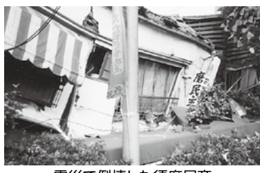
震災で倒壊した須磨民商
